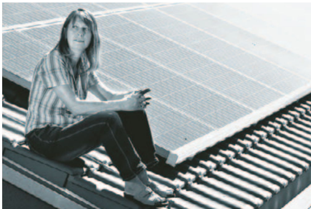
Claudia Pirch-Masloch vom Vorstand des Solarvereins Berlin-Brandenburg sitzt auf dem Dach vom Ökohof Kuhhorst im Havelland. Dort hat der Verein fünf große Solarmodulfelder installiert.
