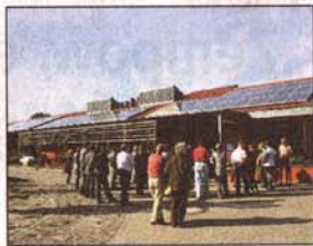
Sieht gut aus und bringt Strom, die Solaranlage.
